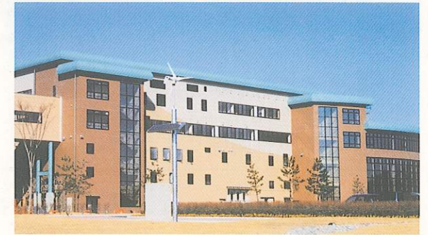
クリーンパーク茂原リサイクルプラザ
